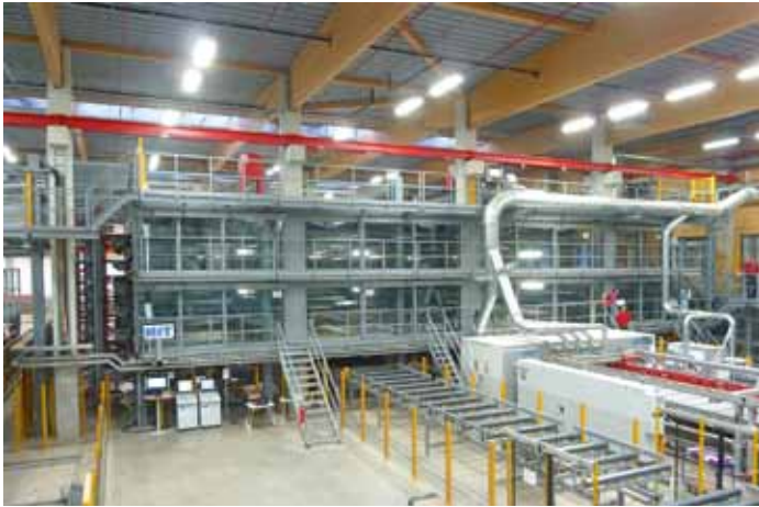
Das beheizte Lamellenlager besitzt sechs Etagen, auf denen die zugeschnittenen Buchen-LVL-Zuschneite zwischengelagert werden
